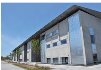
生産技術研究所研究実験棟I
