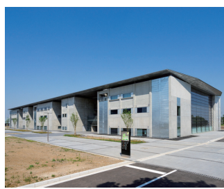
生産技術研究所研究実験棟I
