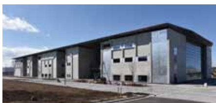
生産技術研究所附属千葉実験所研究実験棟I
